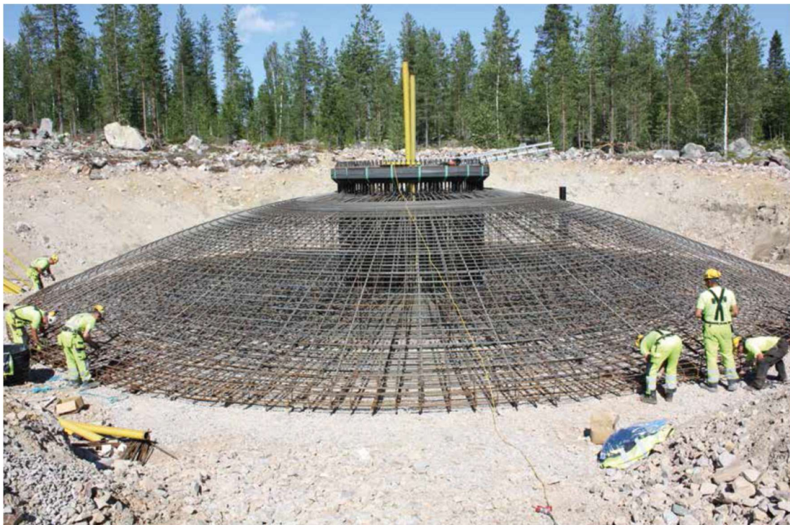
Kuva 3-6 Maanvarainen teräsbetoniperustus raudoitettuna ennen betonivalua.
