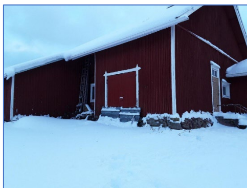
Ristikankaan ulkorakennus © Soinin kunta, 2025
