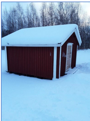
Ristikankaan ulkorakennus © Soinin kunta, 2025
