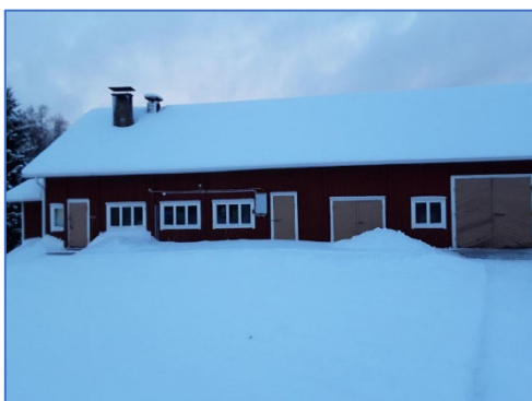
Ristikankaan ulkorakennus © Soinin kunta, 2025
