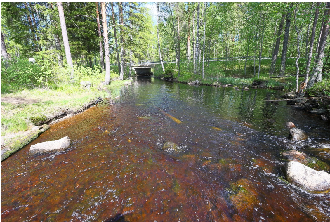
Kuva 5. Hankakosken pato, kuvattu koilliseen. JR 29.5.2026.
